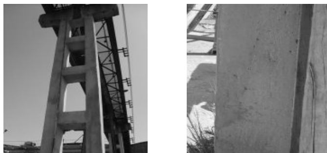
Rys. 5 Żelbetowy słup po renowacji Fig. 5 Reinforced concrete column structure after renovation
